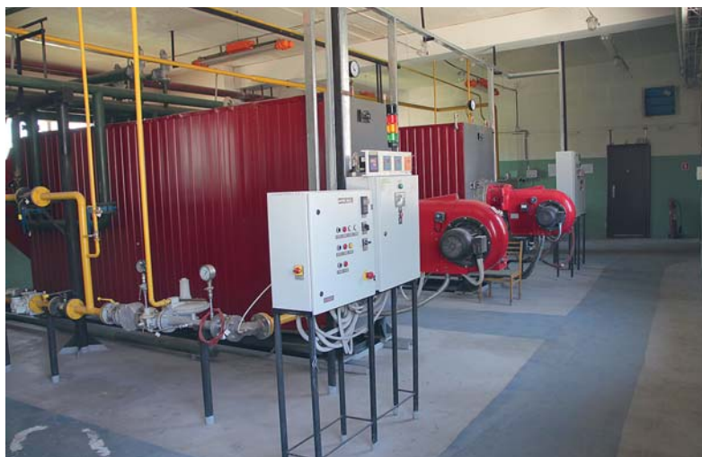
Заводская котельная на основной площадке в г. Луга. Здесь установлены два современных котла производства псковского котельного завода с горелками Weishaupt Monarch
